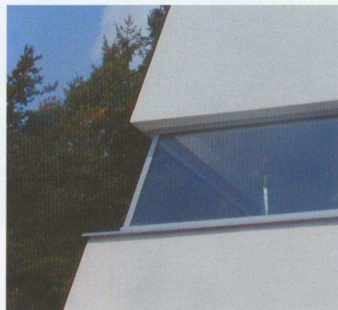
Détail spécial pour fenêtre bois-alu « Alu2Holz » Architecte Hrdlovics, Zirl 2003
